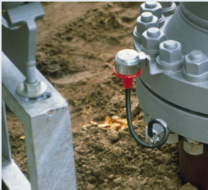
Iskierniki z elastycznymi wyprowadzeniami z atestem ATEX służą do wyrównywania potencjałów w ochronie odgromowej wg PN-EN 62305
