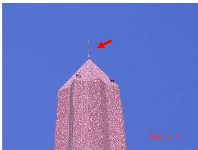
Foto. 6: Zwód ESE na wierzchołku minaretu.
