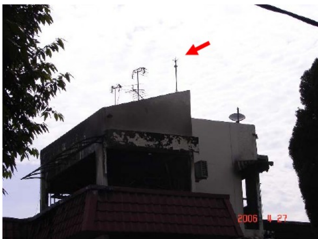
Foto. 4: Zbliżenie zwodu ESE na dachu (strzałka).
