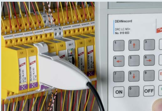
Kontrola modułu ogranicznika ze znacznikiem RFID
