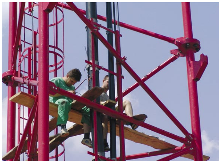
Prace na maszcie antenowym RTCN (widoczny grubszy fider pracuje z mocą 0,5 MW)
